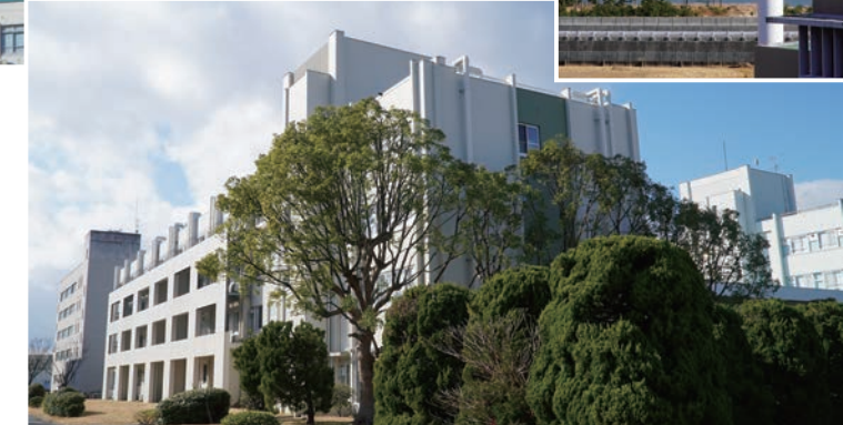
(右下)藤井先生の研究室がある分子素材工学科棟 (右上)海沿いの地形を生かしたスマートキャンパス風力発電設備
